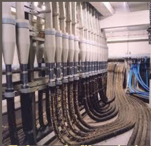
Enlaces de fibra óptica
